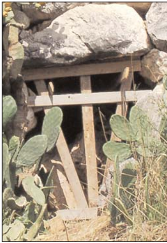
L'impalcatura di protezione
